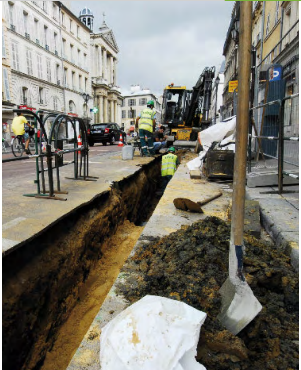
Remplacement des canalisations d'eau potable rue de la Paroisse
