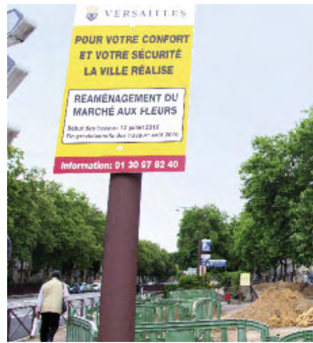
Réfection du terre-plein du Marché aux Fleurs
