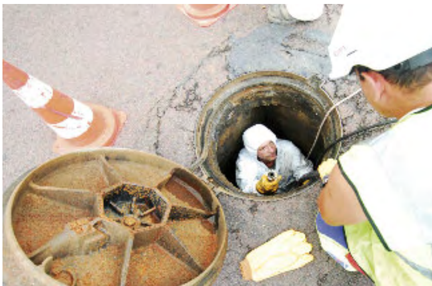
Chemisage par l'intérieur des canalisations de la rue Édouard Lefebvre
