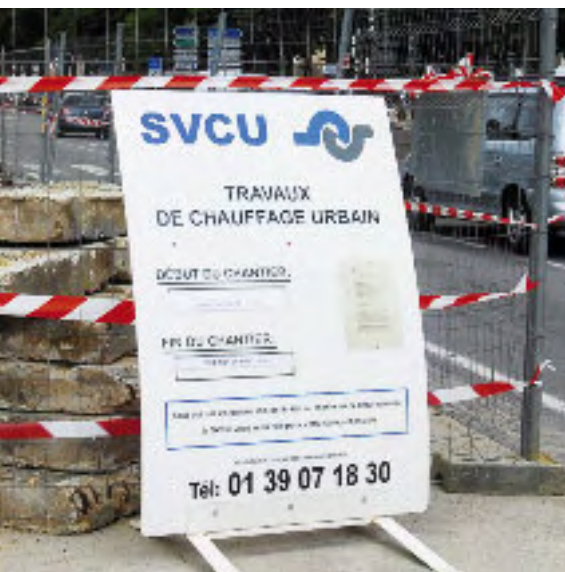
Rénovation des canalisations du chauffage urbain, avenue de Paris
