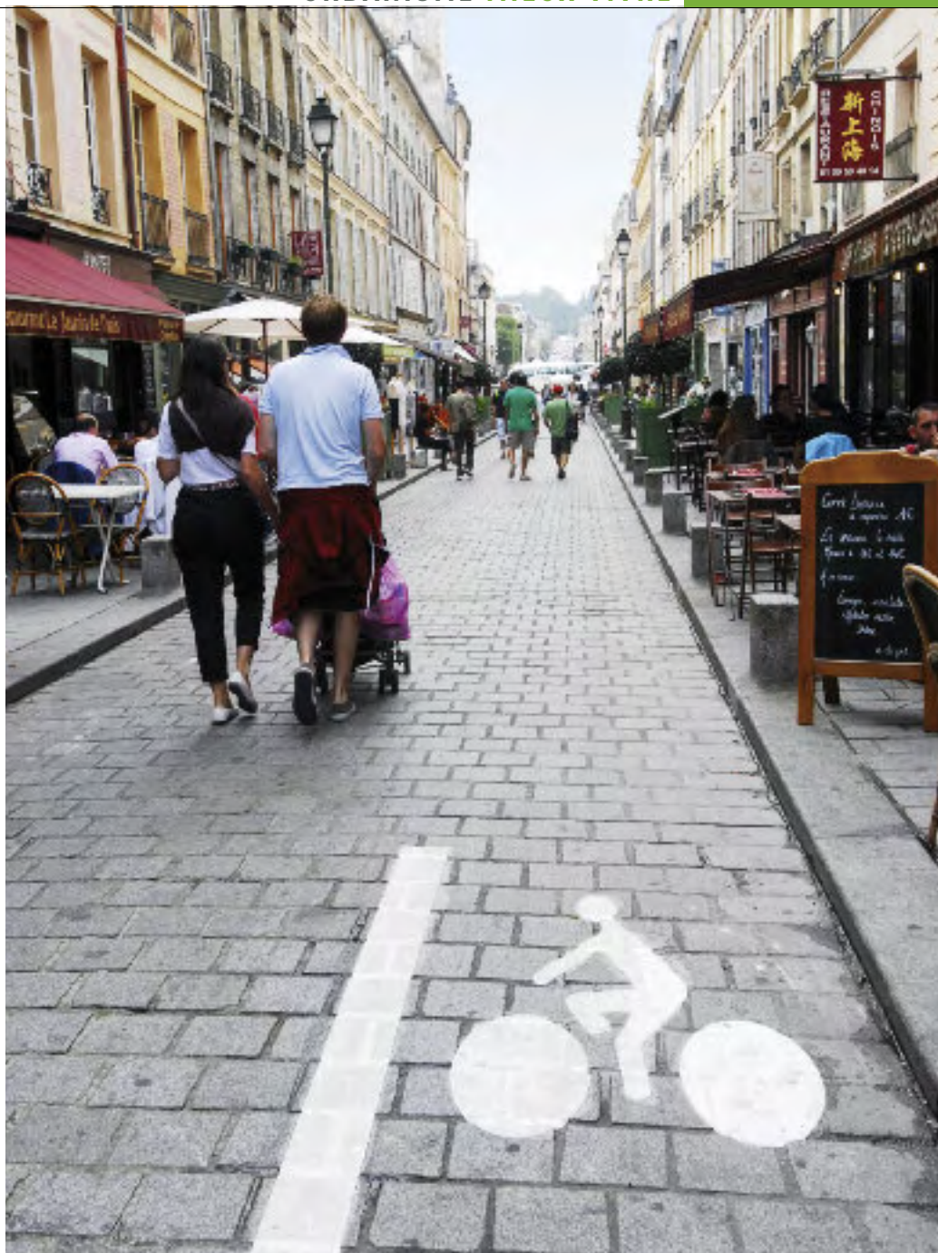
Installation d'un double sens cyclable rue de Satory
